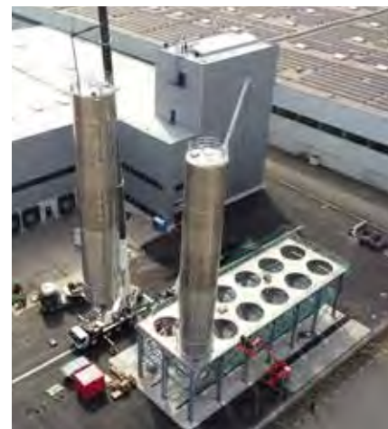
In Rekordzeit wurden die Silos beim Kunden GREIWING in Greven aufgebaut
