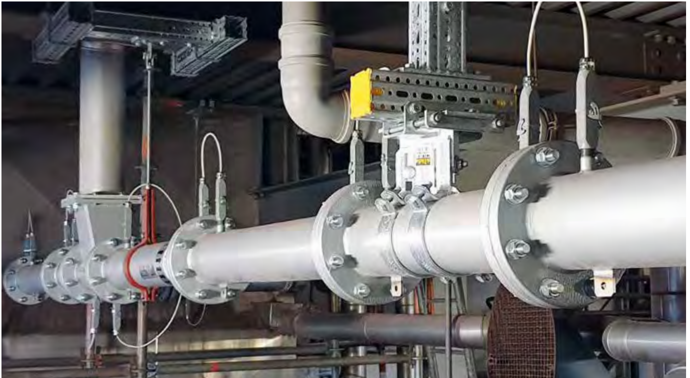
Überwachte Ascheleitung, Innendurchmesser 80 mm
